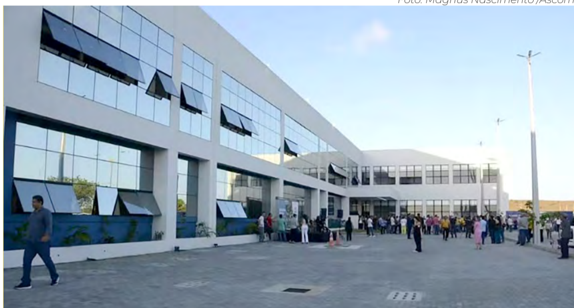
Dentro do bloco já entregue, a unidade hospitalar tem 90 leitos de enfermaria e 10 leitos de UTI
