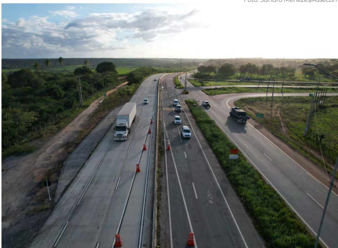
A etapa inicial contemplará a duplicação de aproximadamente 100 quilômetros da rodovia
