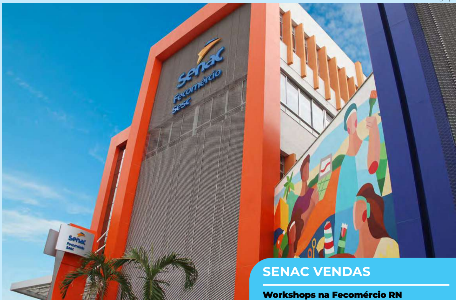
Workshops presenciais acontecem na unidade do Senac Centro
