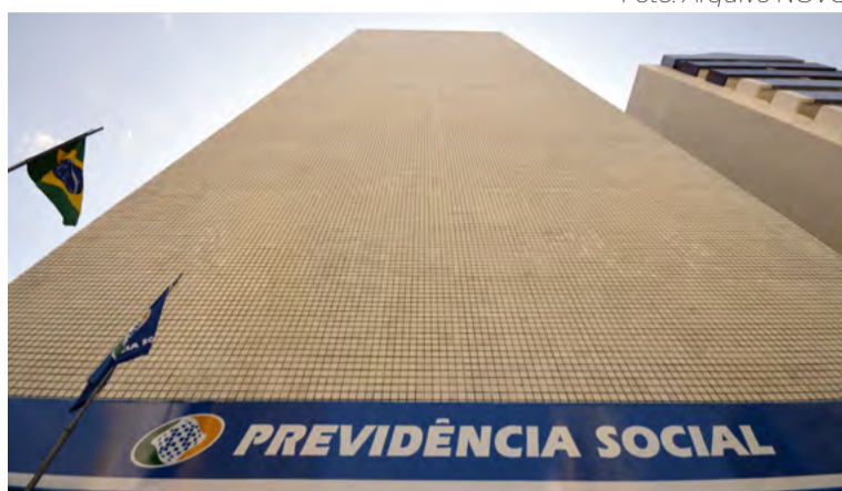
Fachada da superintendência do INSS em Natal
