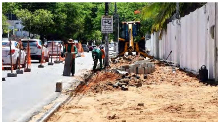
Obras nas calçadas do entorno da Arena das Dunas
