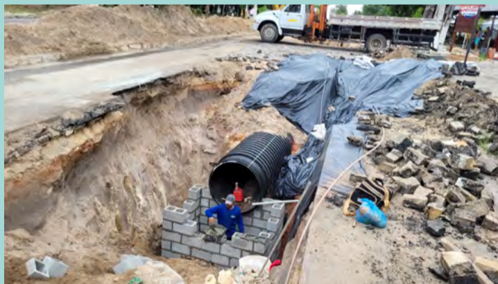
Obra de drenagem no bairro de Neópolis
