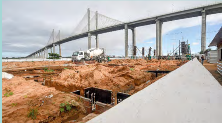
Construção do terminal turístico da Redinha
