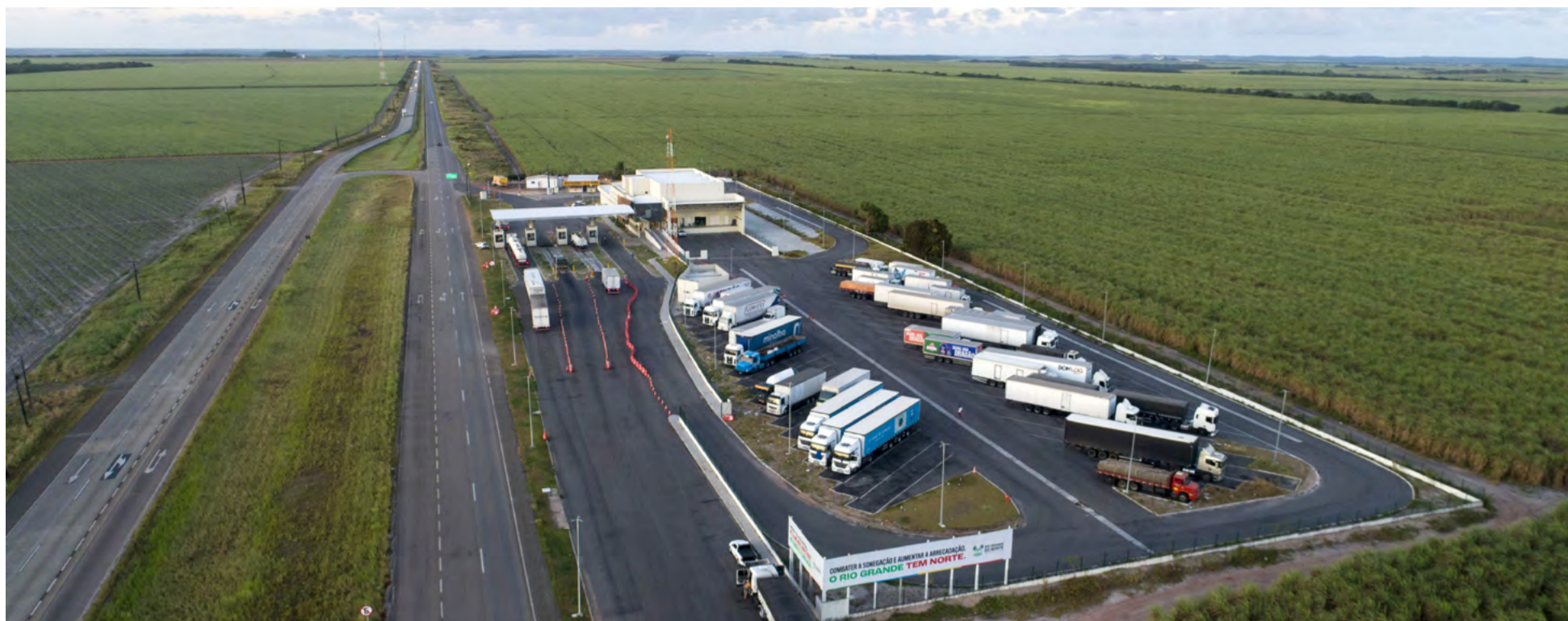
Construção do Núcleo Integrado de Fiscalização de Caraú (NIF), em Baía Formosa, recebeu mais de R$ 30 milhões em investimentos
