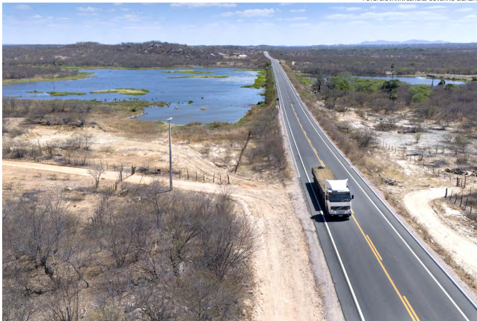
Reconstrução da rodovia RN-233 para o escoamento da produção do Vale do Açu recebeu R$ 74 milhões
