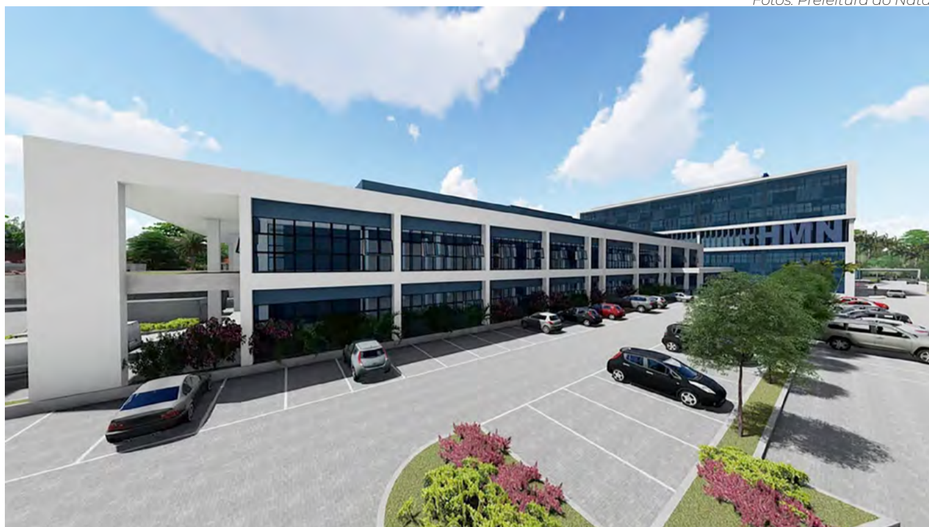
Hospital Municipal está sendo construído em terreno localizado na Avenida Omar O'Grady, no bairro Pitimbu
