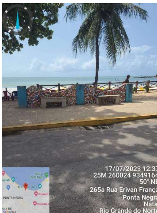
Figura 8: Boca de lobo na Rua Erivan França. Fonte: NCC/IDEMA, 2023.
