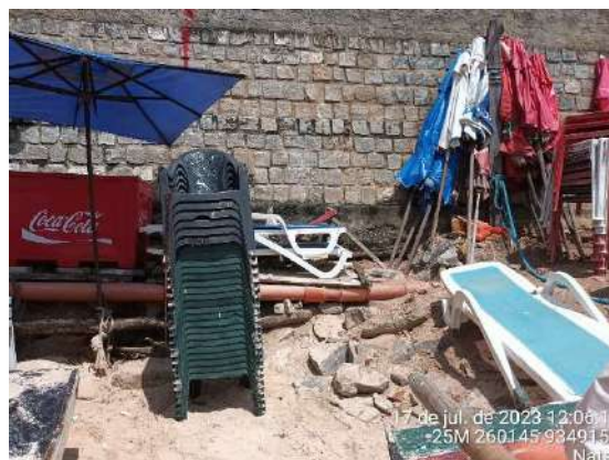
Figura 18: Trecho de tubulação de esgoto em frente ao muro de estabelecimento – já com caimento para ser “enterrada”.
