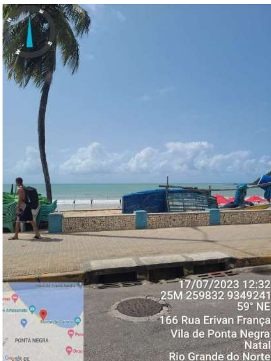
Figura 5: Boca de lobo na Rua Erivan França. Fonte: NCC/IDEMA, 2023.
