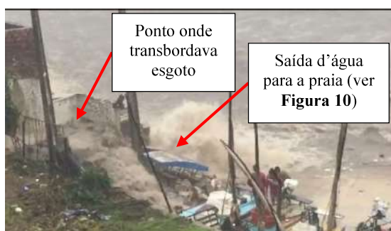
Figura 13: Ponto onde transbordava esgoto no período chuvoso. Fonte: Desconhecida.
