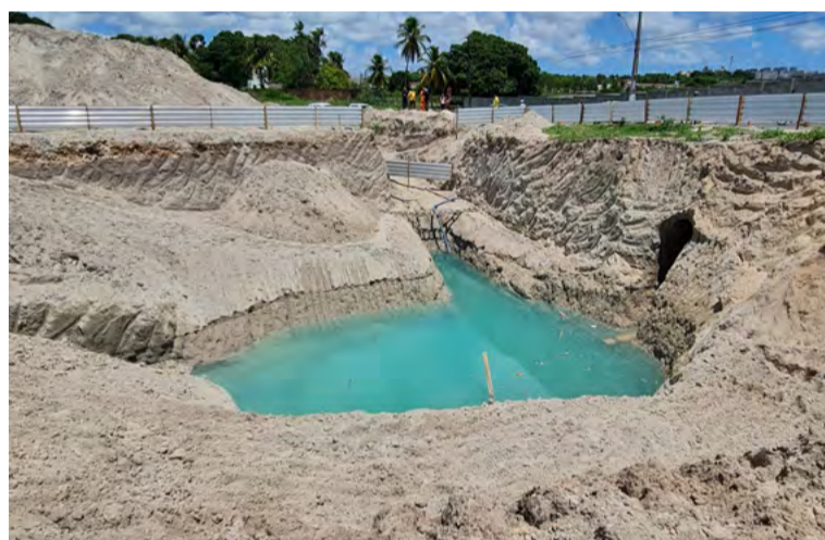
Segundo a Caern, quilômetros de rede já foram concluídos
