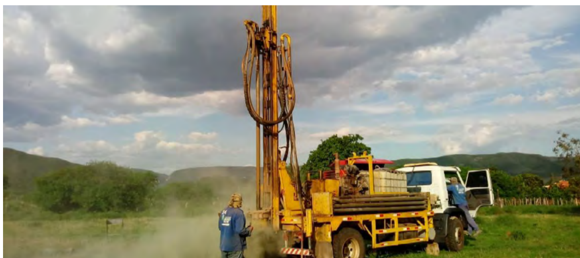
Em 11 meses foram construídos 1.651 poços no RNm, beneficiando mais de 57 mil famílias
