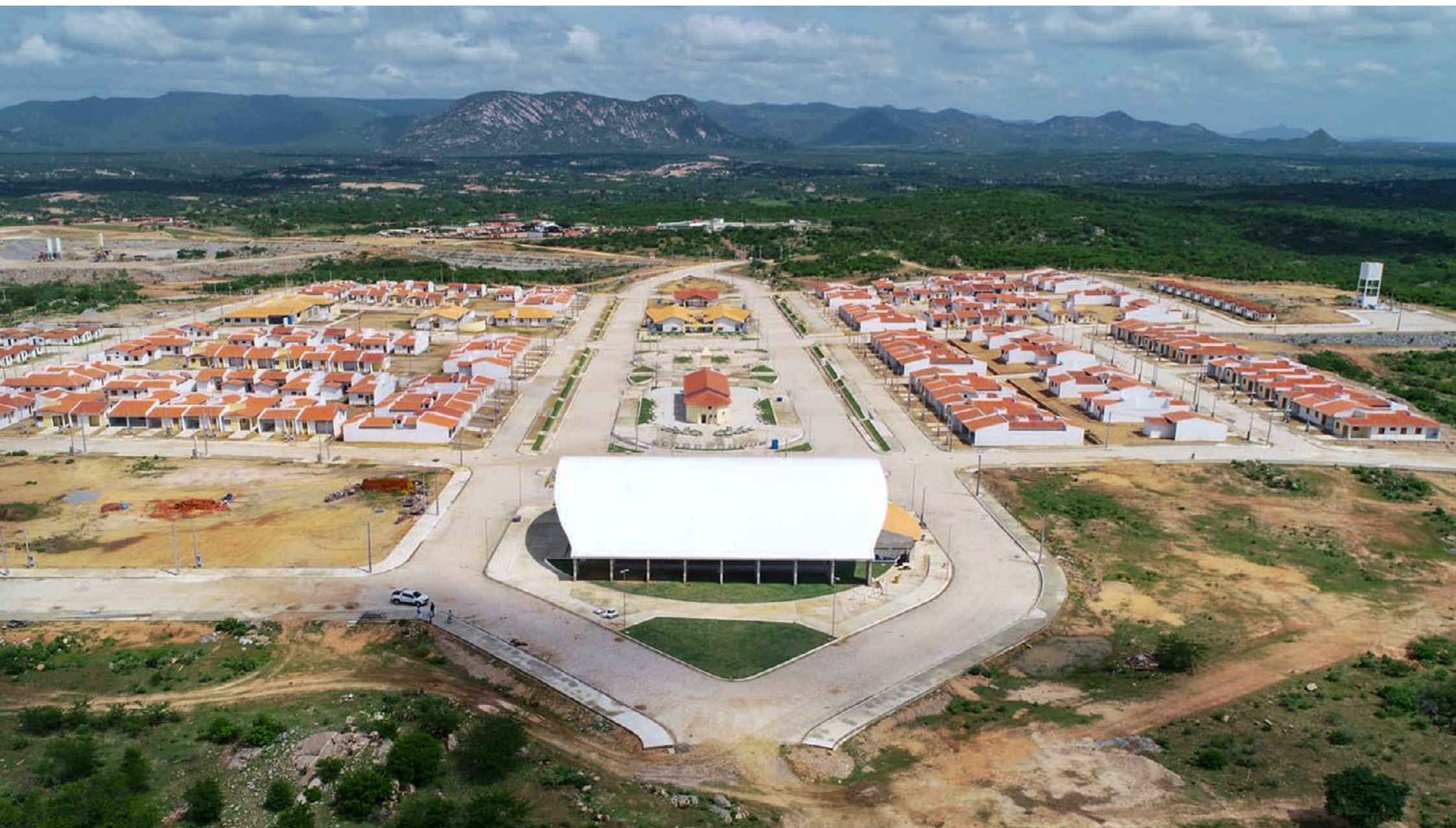
Projeto arquitetônico foi elaborado tendo como base a disposição das casas e dos prédios do Distrito Janúncio Afonso (mais conhecido como Barra de Santana) em Jucurutu, e a preocupação de manter o perfil de convivência social das famílias
