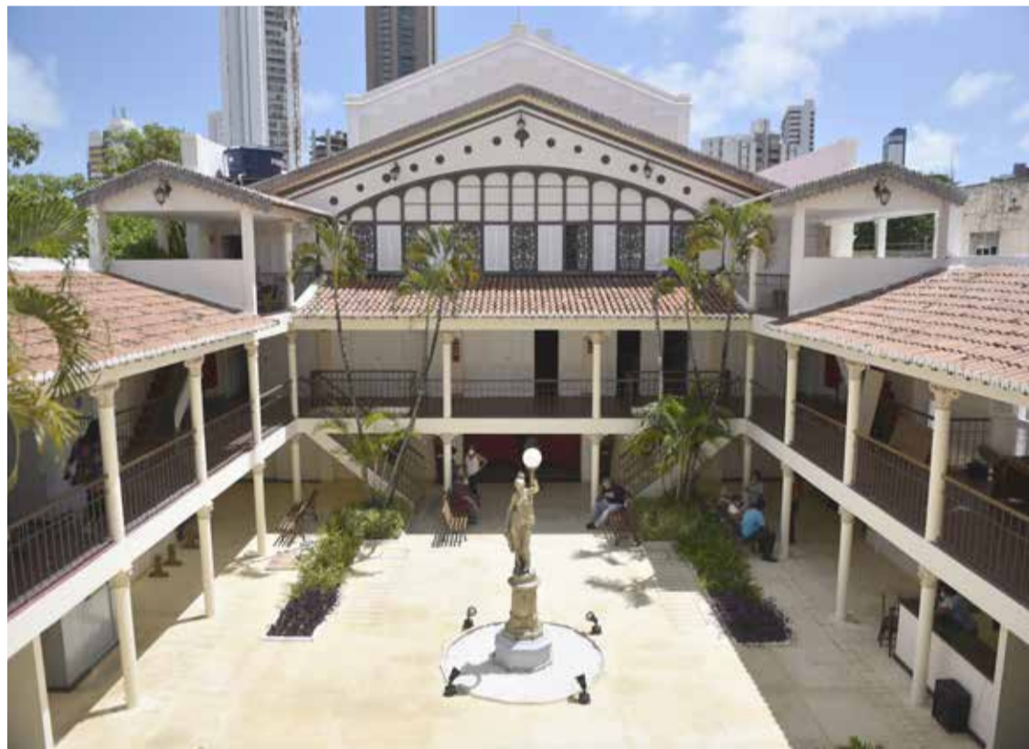
Jardim central retorna às características originais, e a estrutura do telhado foi totalmente reconstituída e reforçada
