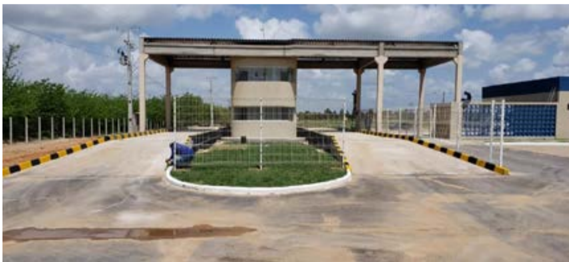
A CTR Potiguar conta com toda segurança ambiental para destinação de resíduos
